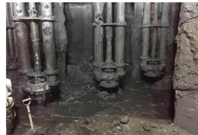
**Casa de bombas en Minera Chuquicamata afectada por un proceso de pobre floculación**
