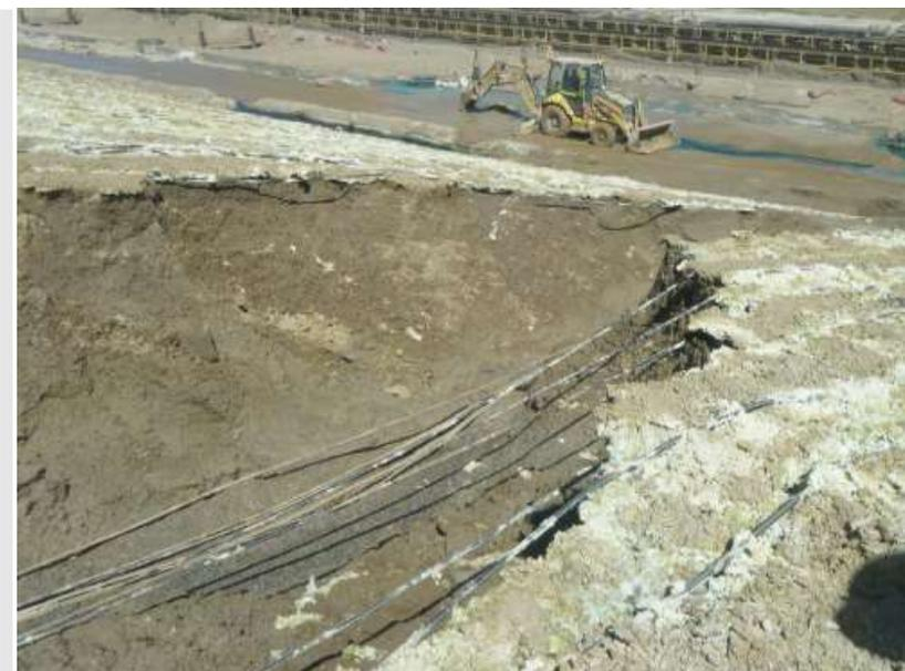
*Deslizamiento en los taludes por efecto de riego en exceso o mal drenaje del depósito.*
